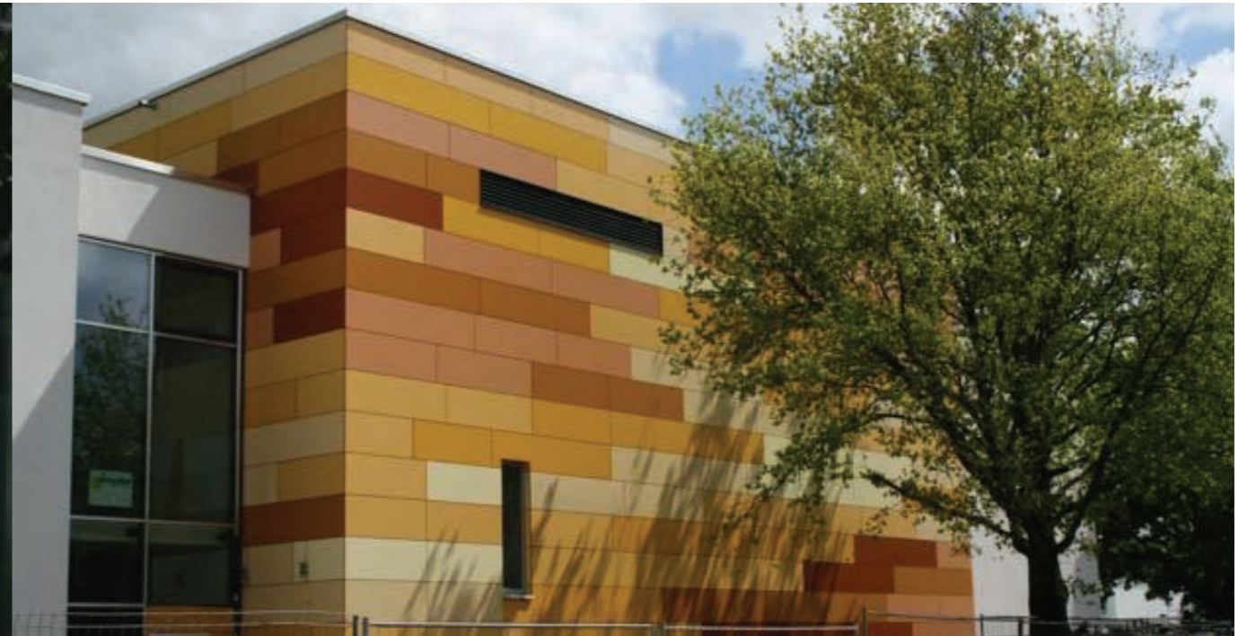
Abb. 2 Die neue Fassade der Aula
